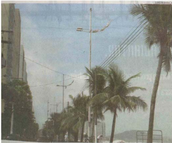
... informou que 100 refletores terão suas lâmpadas substituídas no trecho da orla e proximidades
